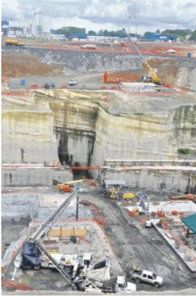
Auf der Atlantikseite nimmt die Hauptkammer der neuen Schleuse allmählich sichtbare Formen an. Da würde eine vierstöckiges Gebäude reinpassen.
